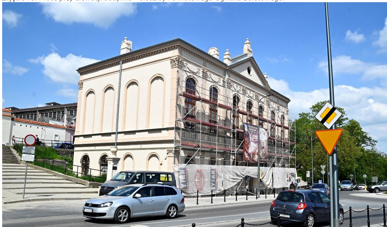
Zdjęcie 75. Prace przy elewacji budynku – siedziby Powiatowego Ogniska Baletowego.
